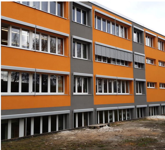
Abb. 2. Sanierte „Tälerschule“ Ottendorf (2023)
